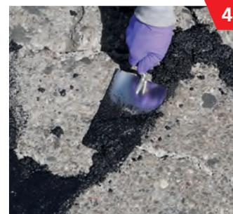
4 Die fertige Mischung mit einer Kelle auftragen und anschließend glätten – kein Verdichten notwendig.
